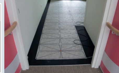
Abb. 2: Installation des SensFloor Underlay in einem Pflegezimmer, Randbereiche mit Ausgleichsvlies belegt.
