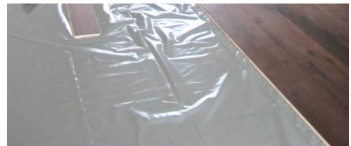
Bild 34: Schwimmende Parkettverlegung auf SensFloor mit PE Folie als Feuchtigkeitssperre
