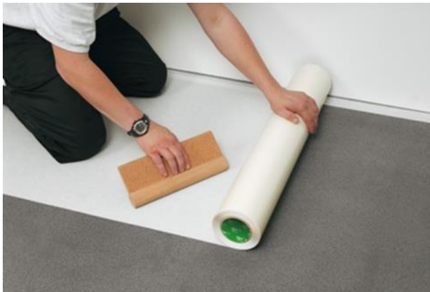
Bild 11: Verlegung der doppelseitigen Klebefolie
