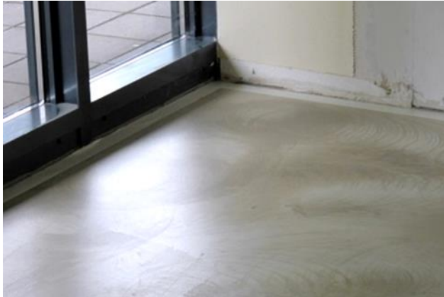
Bild 9: Gespachtelter und geschliffener Estrich.
