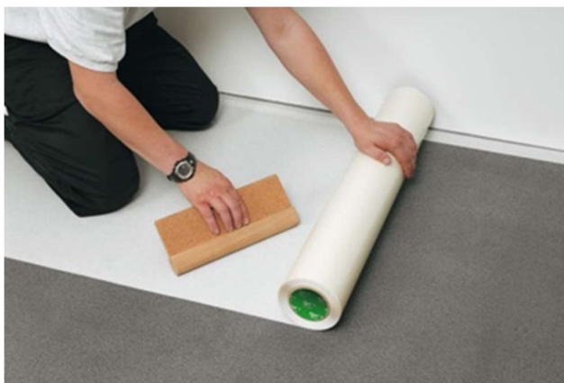
Image 11 : Pose du film adhésif double face
