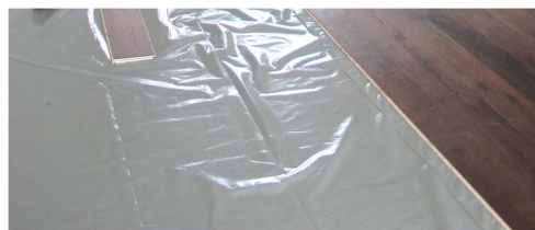
Image 34 : Pose de parquet flottant sur le SensFloor avec film PE comme barrière contre l'humidité
