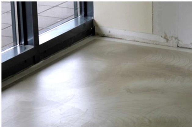
Image 9 : Chape lissée et poncée
