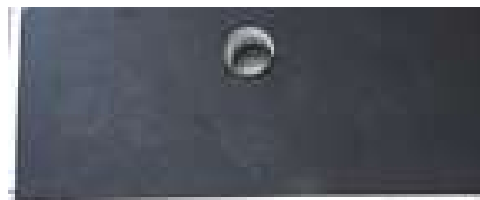
Image 33 : Ouverture pour l'évacuation des eaux dans le sol
